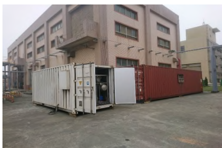
圖 1、現場測試設備
